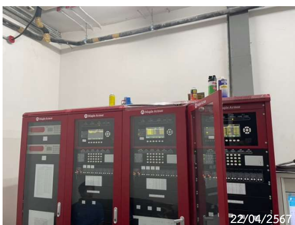
ตู้ควบคุมระบบสัญญาณแจ้งเหตุเพลิงไหม้ (Fire Alarm Control Panel)
